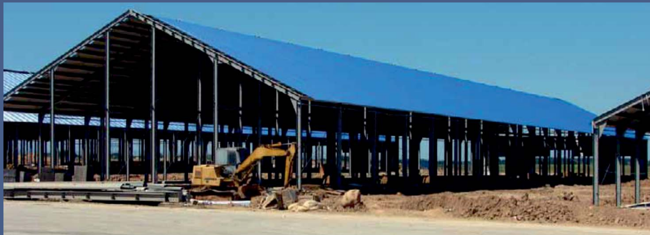
Родильное отделение. Габаритные размеры 32X72 Высота до низа несущих конструкций - 4,6 м Площадь 2 325 кв.м
