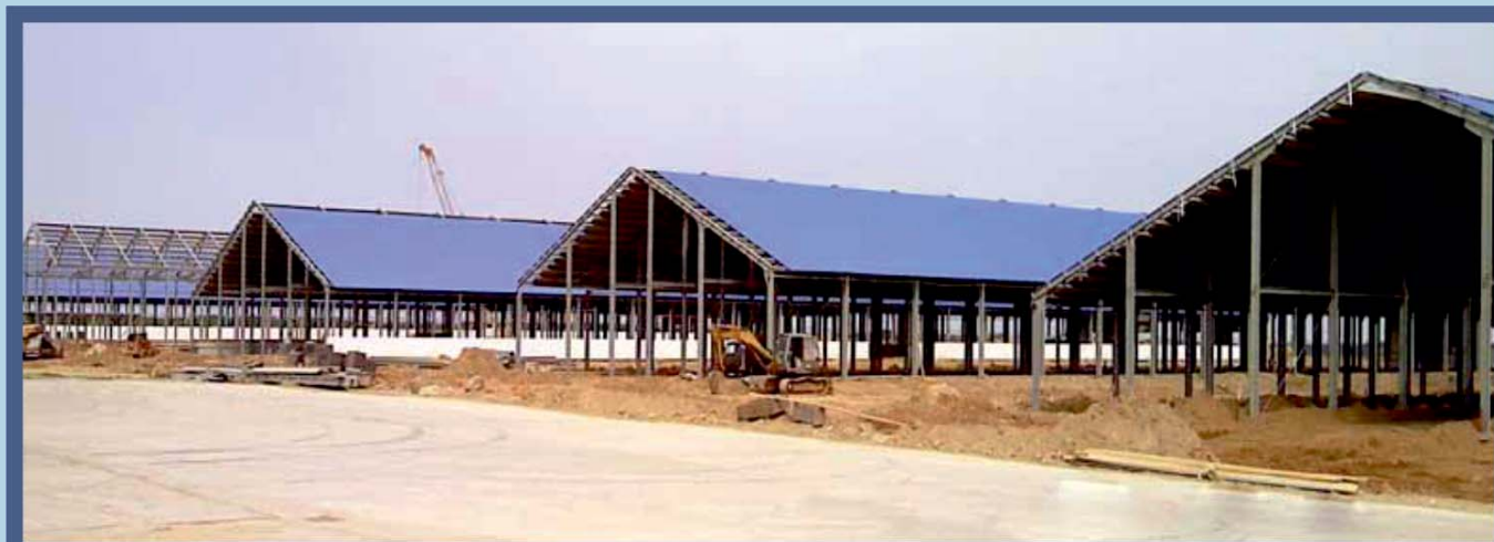
Дойно-молочный блок Габаритные размеры 21X66 Высота до низа несущих конструкций - 4,65 м Площадь 1 456 кв.м
